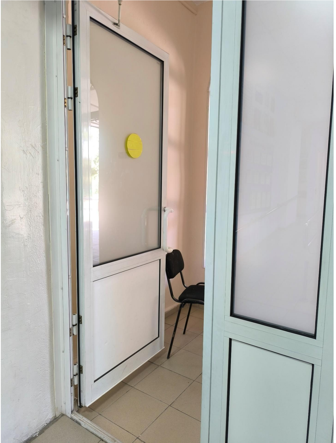
Фото 11 - дверь коридор главный корпус
