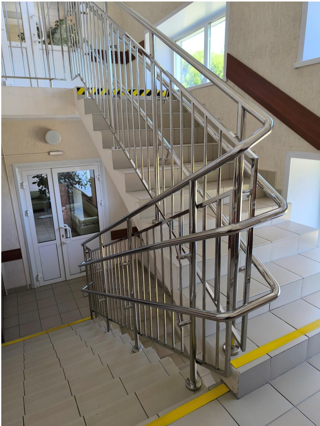
Фото 10 - лестница на 2 этаж главный корпус
