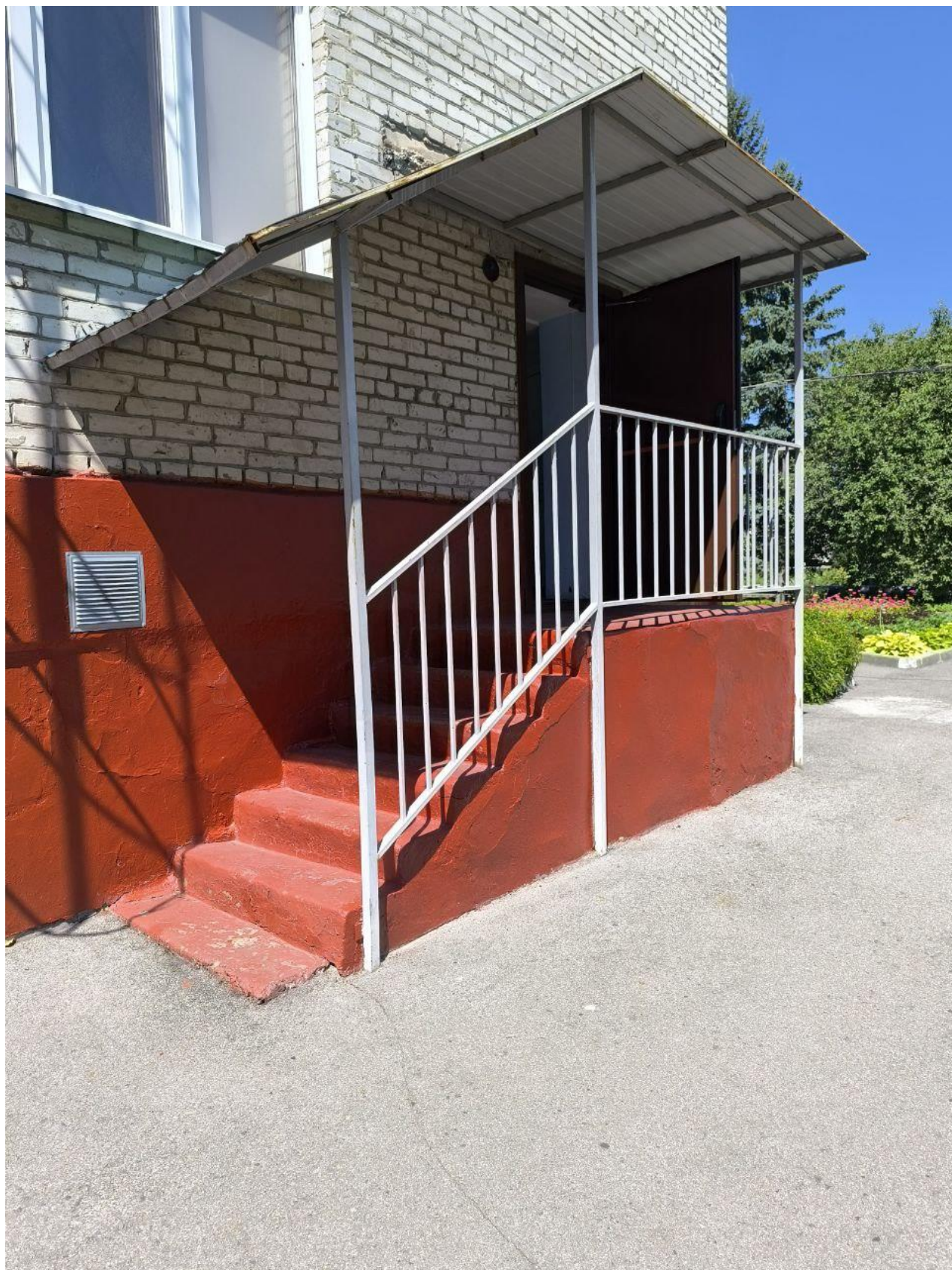
фото 8 - запасный вход в главный корпус
