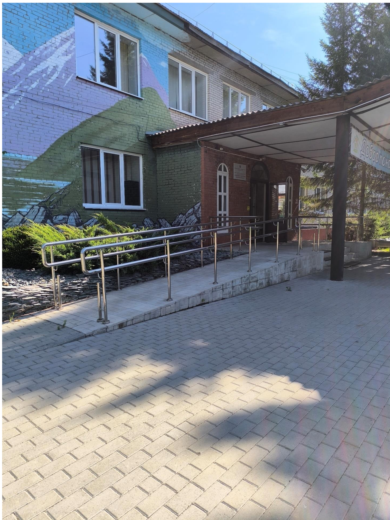
Фото 6 - пандус у главного входа в здание
