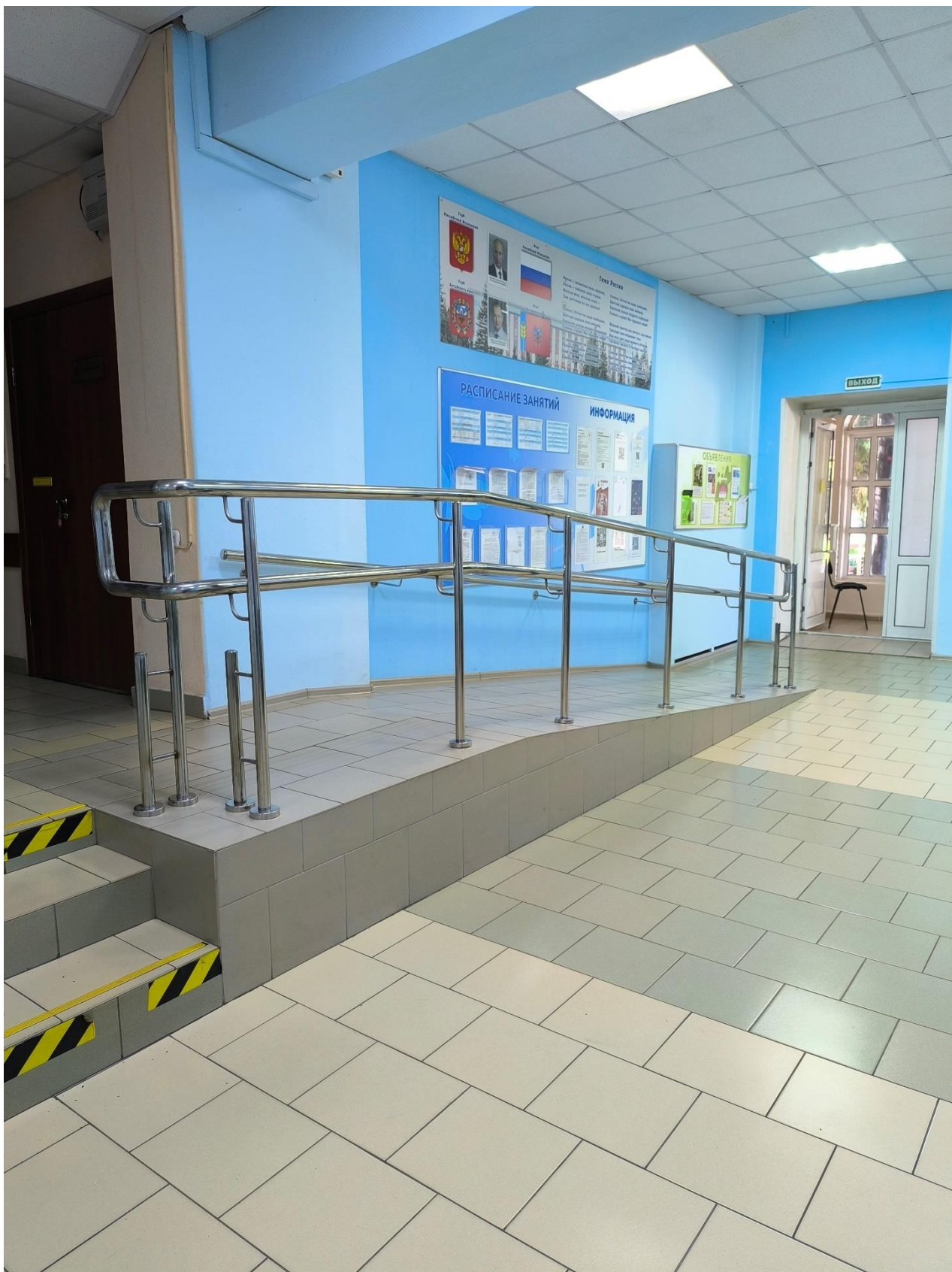
Фото 9 - пандус 1 этаж главного корпуса
