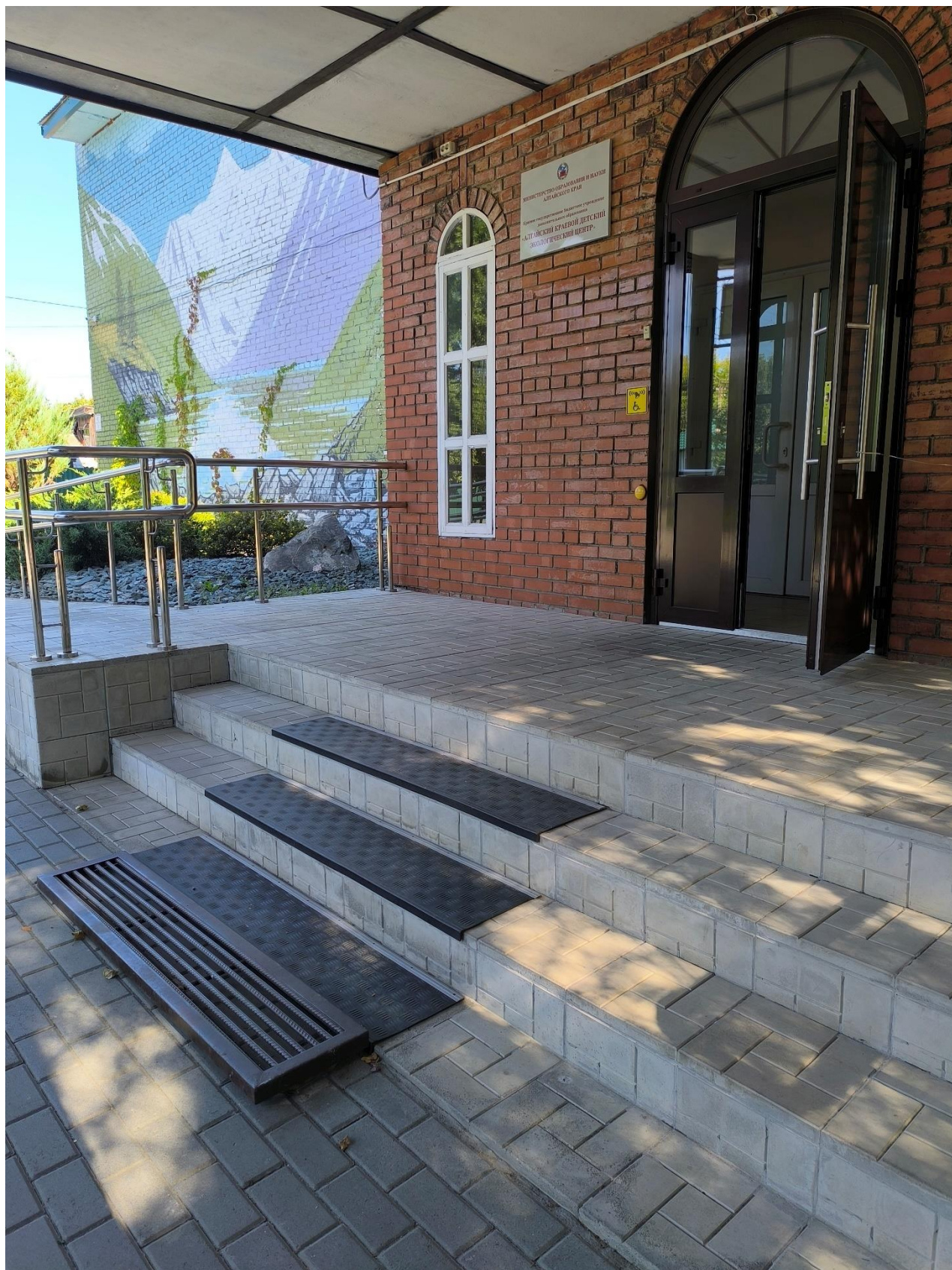
Фото 7 - площадка перед входом
